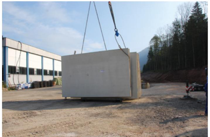
Schritt 2: Wandelement anheben und mit dem 2. Gehänge und langsam drehen.
